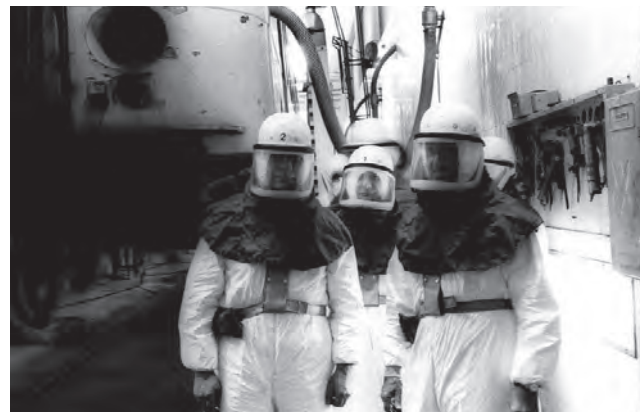
↑ Operai al lavoro presso i "binari protetti", OGR di Bologna.
